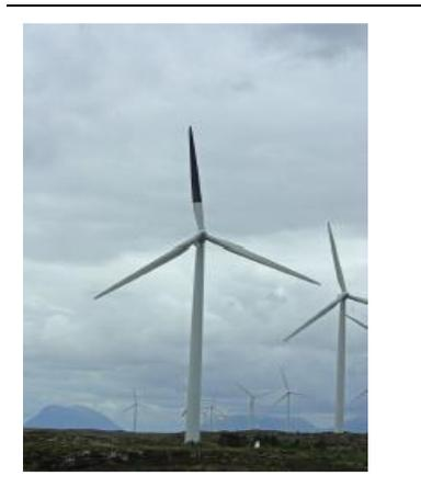
Figura 1.6.5.7.1. Ejemplo de aerogenerador con la pala del rotor pintada de negro
