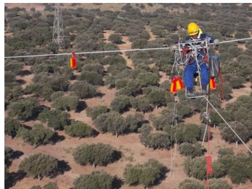
Foto 3 Señalización con aspás en cable de tierra
