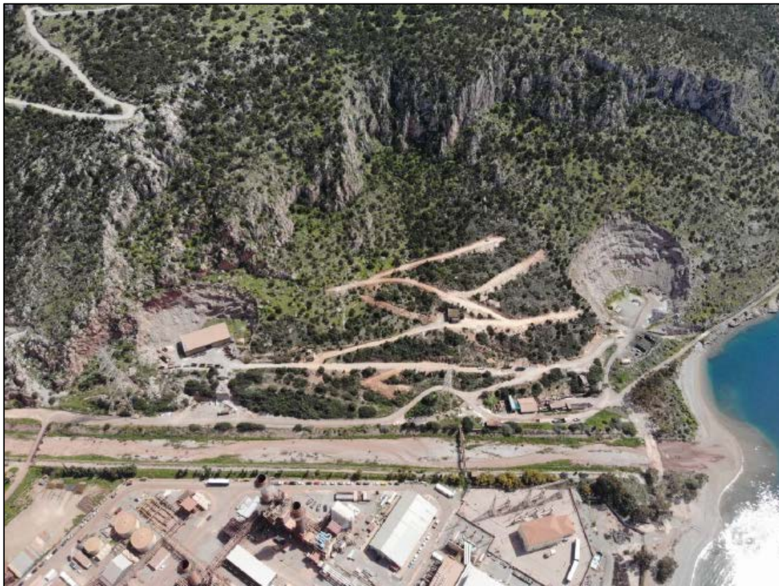
Σχήμα 2.1-1: Άποψη περιοχής ανάπτυξης νέου Σταθμού
