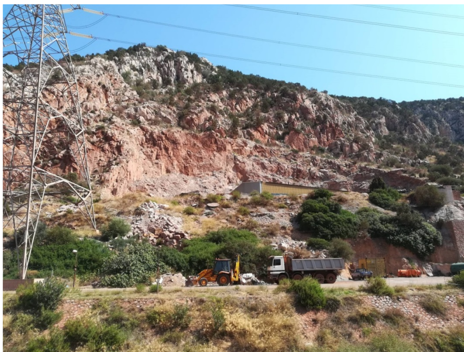
Θέση 3: Χώρος εγκατάστασης πύργων ψύξης
