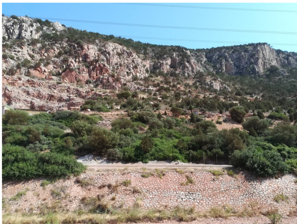
Θέση 4: Χώρος ανέγερσης εγκαταστάσεων νέου Σταθμού
