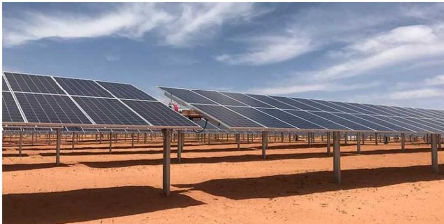
Figura 1.4.4.c. Seguidor monofila 2V. Fuente: Proyecto PSF Solaria-Añoover I.
