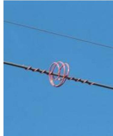
Figure 63 : Exemple d'une balise PVC rouge installée sur un câble conducteur
