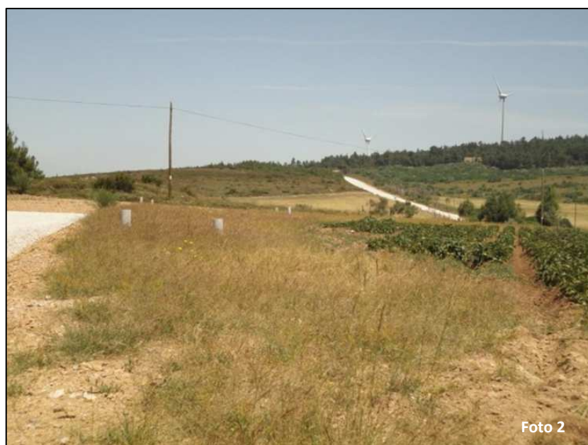
FIG. 1. 5 – Recuperação das Áreas de Intervenção (Foto 1 – Plataformas de Montagem; Foto 2 – Vala de Cabos)
