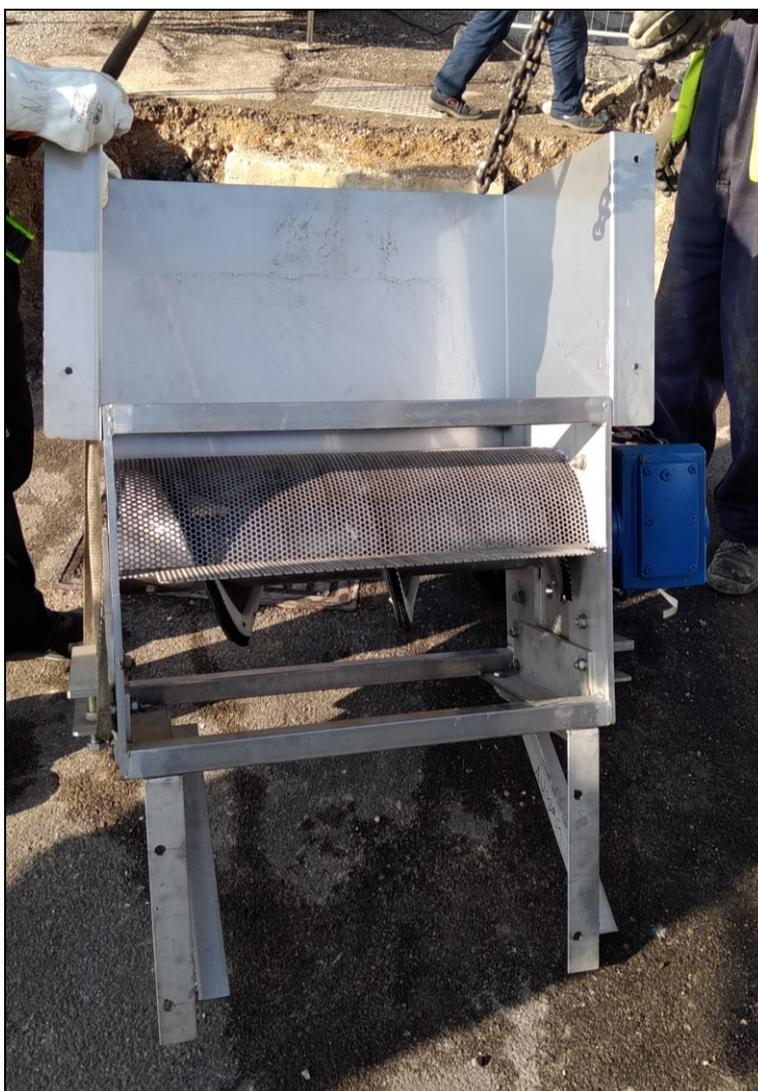
**Figura 3.1 – Impianto di grigliatura fine del refluo sfiorato installato nell’impianto di sollevamento “Pigna” di S.Ambrogio d/V (prog. 16019 1° stralcio).**
