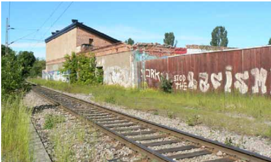
Figur 5.2.4 Före detta industribyggnad sedd från Värtabanan.
