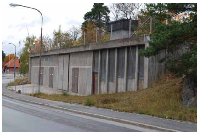
Figur 5.8.1 Transformatorstation på Björnnäsvägen. Stationen inrymmer SL:s likriktarstation och Fortums transformatorstation som försörjer tunnelbanan respektive närområdet med el.
