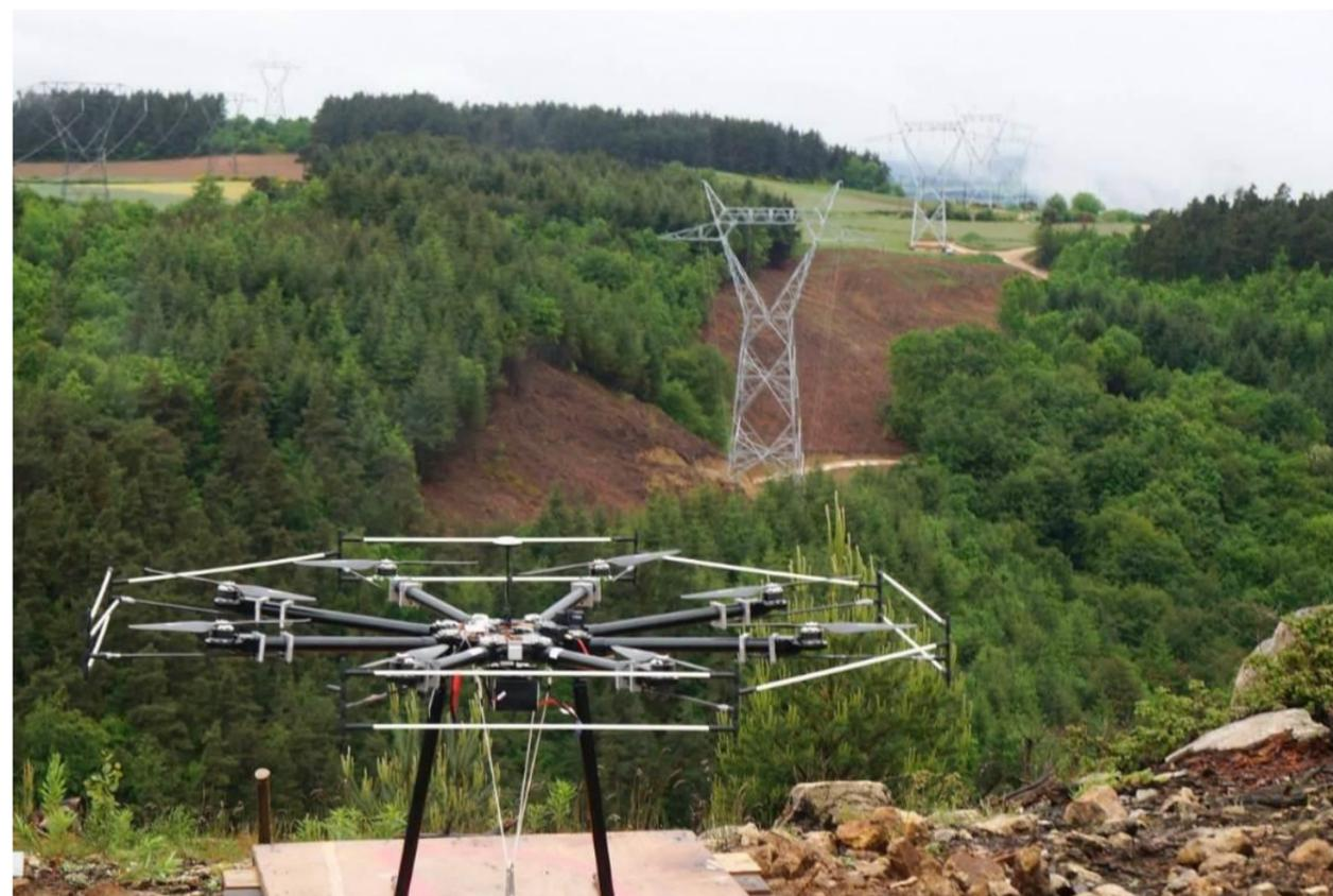
**Figure 28 : Préparation du déroulage par drone sur une ligne électrique à 225 kV (source : Groupement POMA)**
