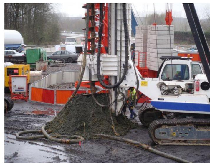
Figure 7 : Bétonnage d'un pieu à la tarière creuse (source : Groupement POMA, 2016)
