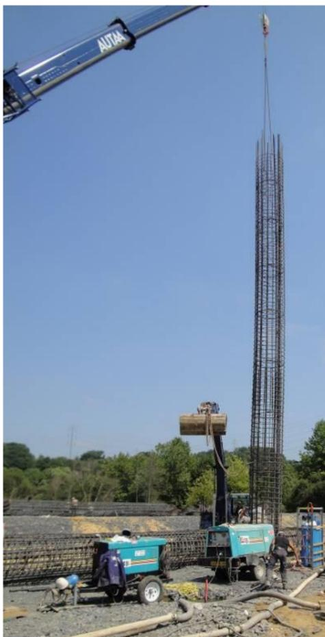
Figure 8 : Mise en place de la cage d'armatures (source : Groupement POMA, 2016)
