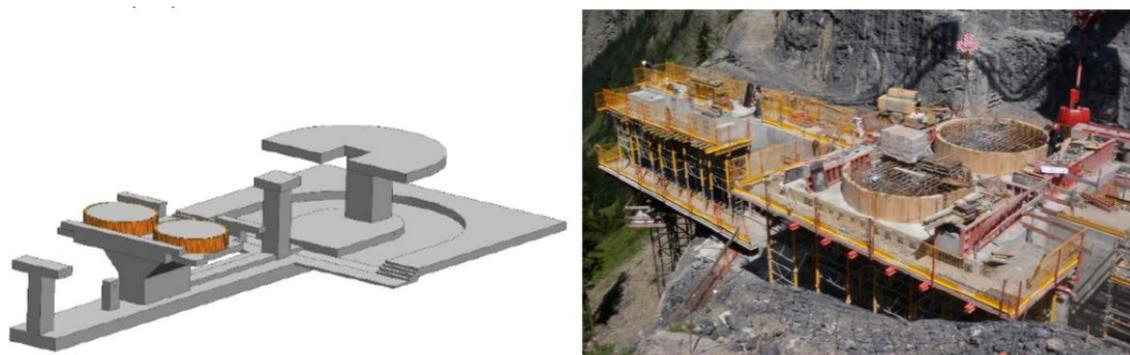
Figure 19 : mise en place de la structure béton (source : Groupement POMA, 2016)
