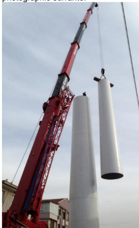
Figure 12 : Montage en cours d'un pylône de type éolien (source : Groupement POMA, 2016)
