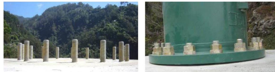
Figure 11 : Ancrage prêt à recevoir la base du pylône, puis pylône fixé au massif (source : Groupement POMA, 2016)
