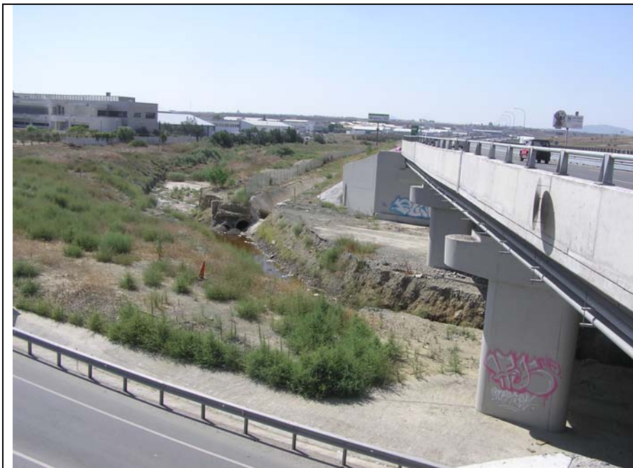
Γέφυρα Αλυκού Α/Δ Λευκωσίας - Λεμεσού
