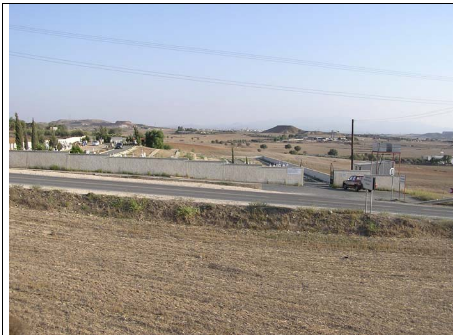
Περιοχή όδευσης Περιμετρικού κοντά στον κόμβο Βιολογικού
