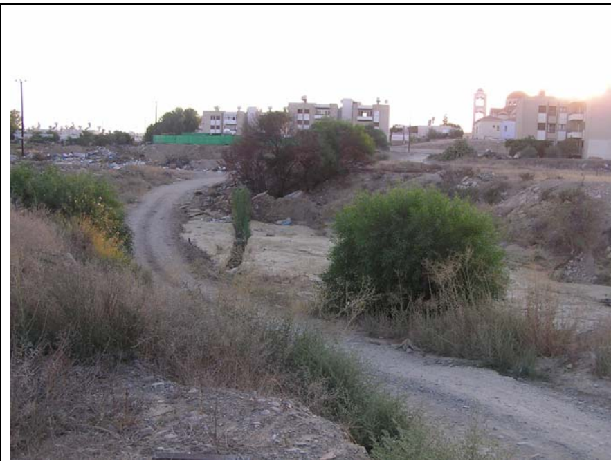
Περιοχή γέφυρας Πεδιαίου
