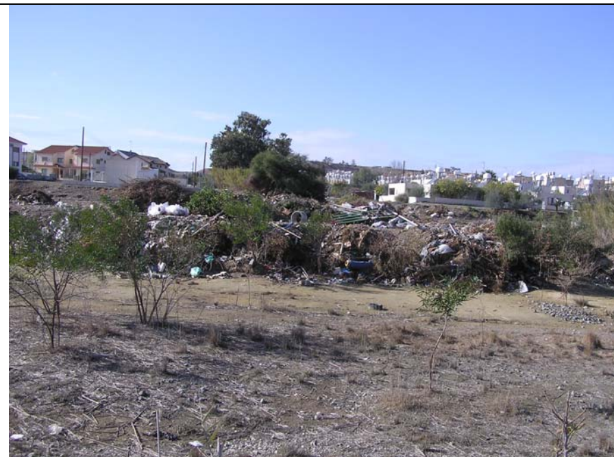
Περιοχή γέφυρας Πεδιαίος
