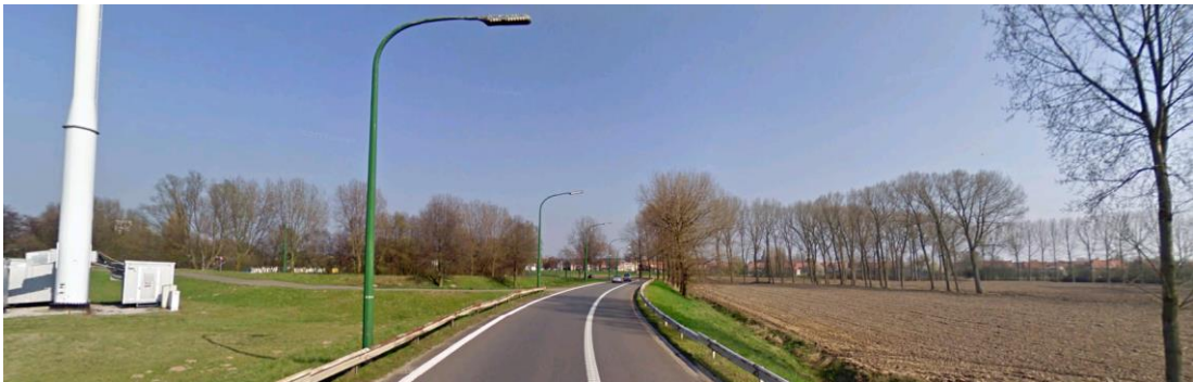
Zicht op te supprimeren zuidelijke afrit van complex Zwijndrecht
