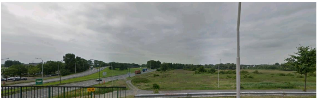
Zicht op E34 en zone voor parallelweg, P&R-gebouw en complex Blancefloerlaan vanuit het noorden (brug Blancefloerlaan)
