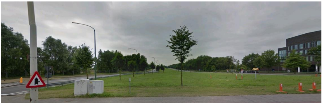
Zicht op te supprimeren op- en afrit Linkeroever vanaf de Blancefloerlaan
