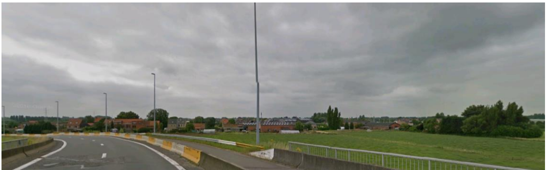
Zicht op woningen Neerstraat vanaf de supprimeren brug van complex Waaslandhaven-oost (ten westen van geplande kluifrotonde)
