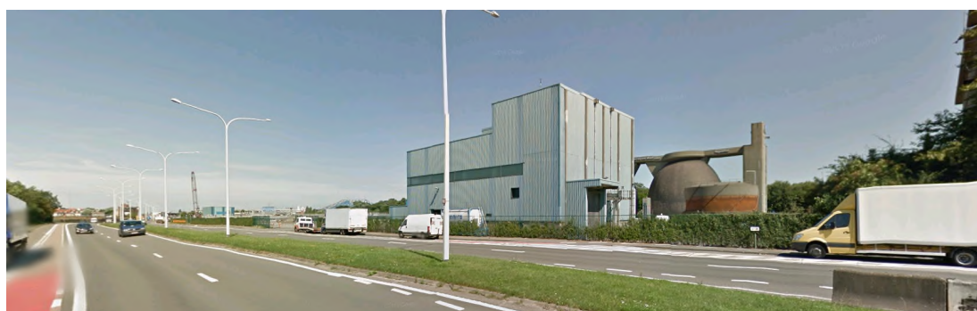
Singel met gebouwen waterzuiveringsstation Deurne
