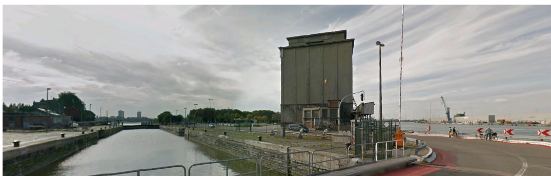
Royerssluis en oostelijke SAMGA-loods met op achtergrond woontorens Linkeroever, Noordkasteelsite en Amerikadok
