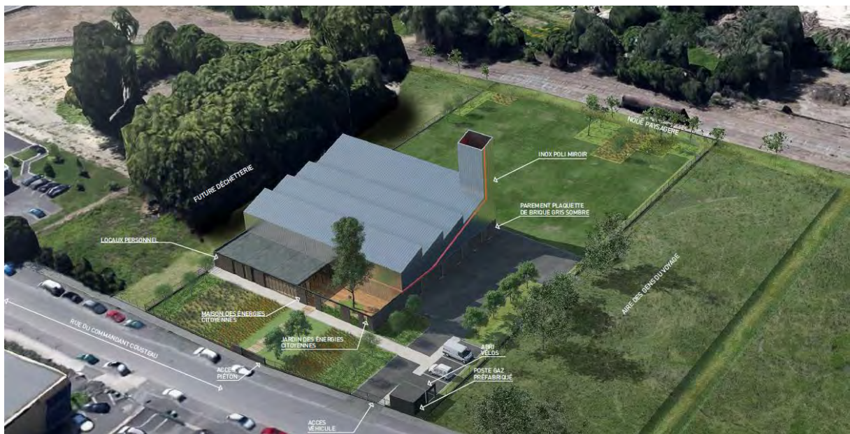
Vue aérienne de la chaufferie centrale du projet Plaines de Garonne Energies
