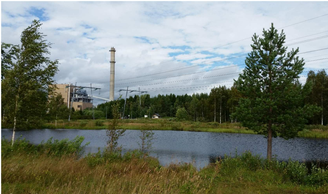
Kuva 6-13. Kanteleen Voima Oy:n voimalaitos. Näkymä Turvetielle. (Kuva: ÅF-Consult Oy)
