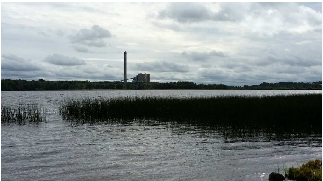
Kuva 6-15. Kanteleen Voima Oy:n voimalaitos. Näkymä Haapaveden keskustan suunnalta Hiukarinniemen uimarannalta. (Kuva: ÅF-Consult Oy)
