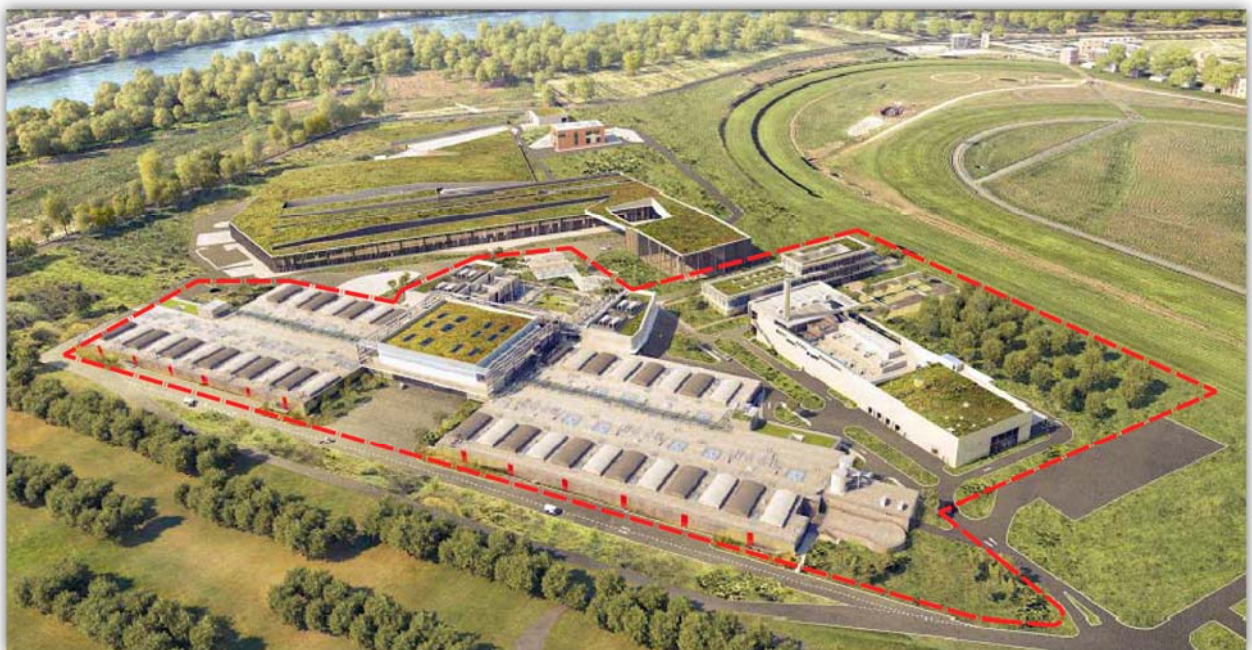
Vue d'ensemble sur la future décantation
