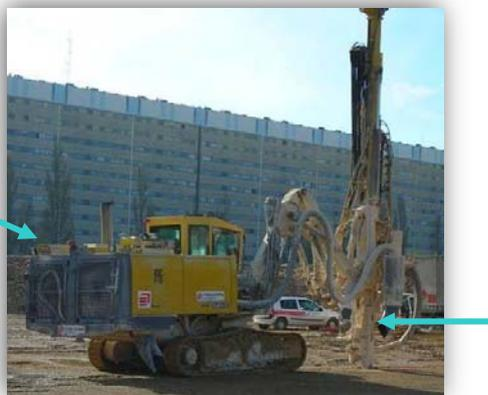
**Figure 114 - Dispositif d'aspiration / évacuation
