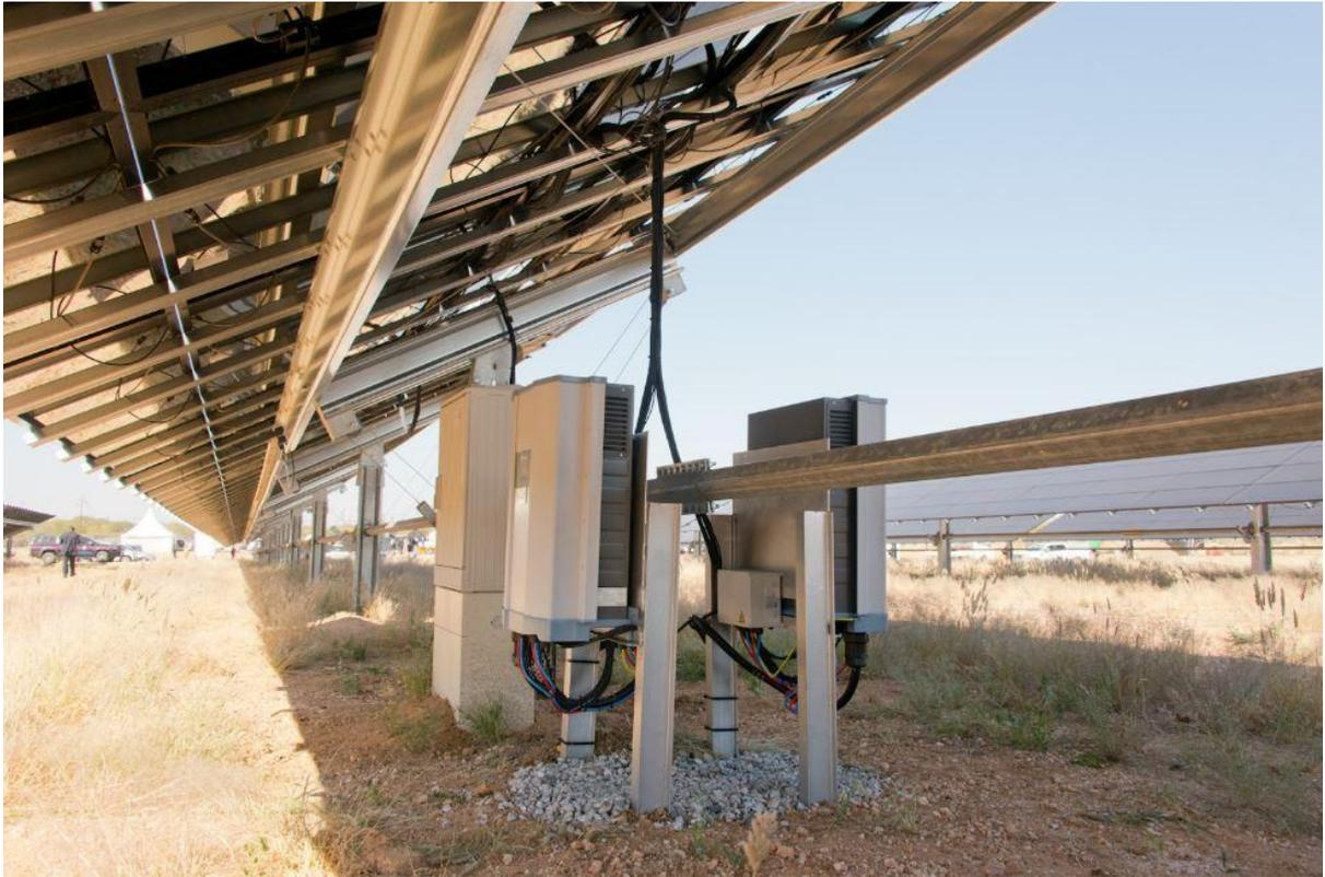
**Figure 8 : Exemple d'onduleurs décentralisés installés par Innovent**
