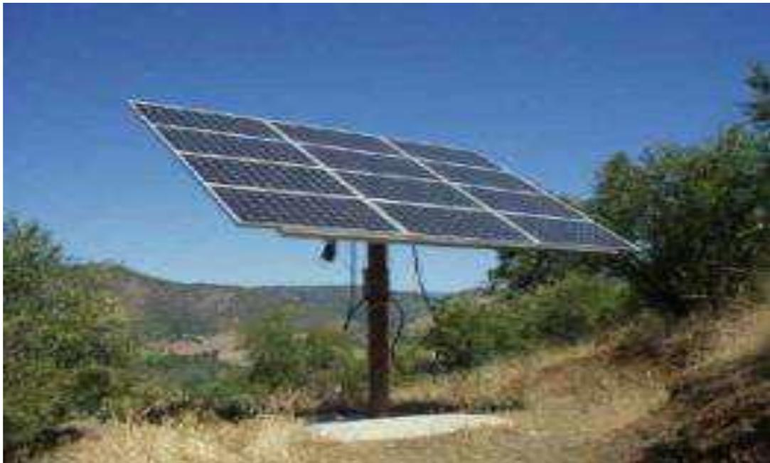
**Figure 6 : Exemple d'un panneau solaire en système tracker à 1 axe**
