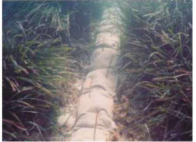
**Photo d'un exemple de section de câble sans coquilles de protection, maintenue au moyen de sacs de béton**
