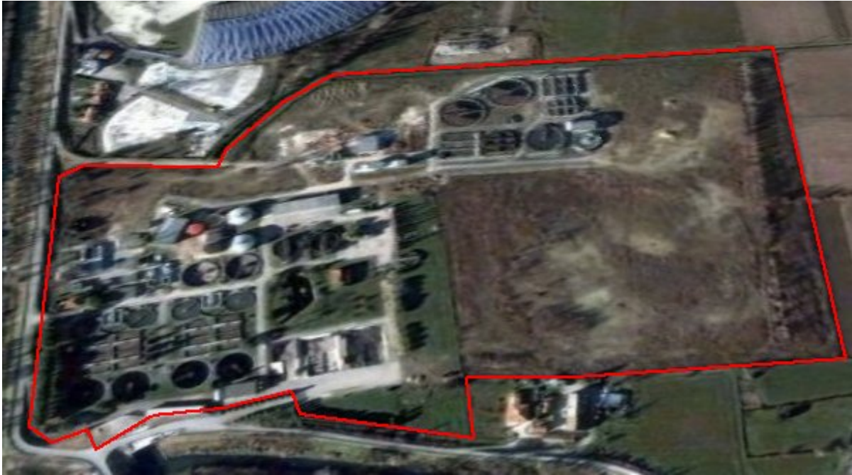
Figura 14: Impianto di depurazione di Cà Nordio: Veduta dell'area dell'impianto prima dell'intervento di ampliamento (foto: google hearth)
