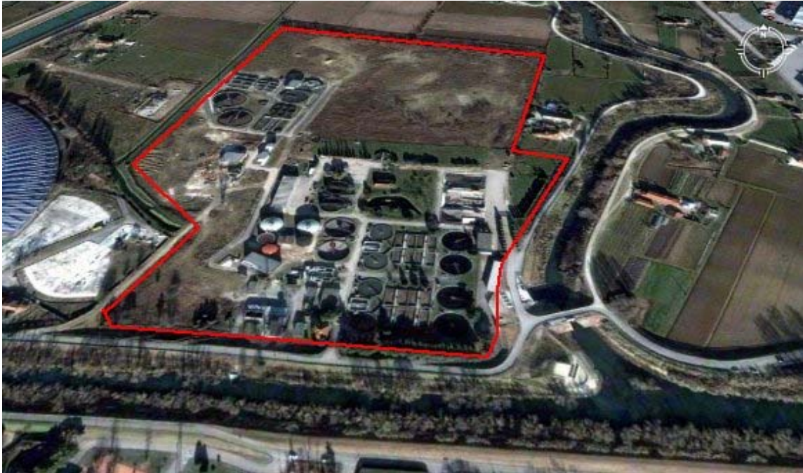
Figura 2: Localizzazione dell'impianto di depurazione di Ca' Nordio a Padova, inclusa l'Area di ampliamento
