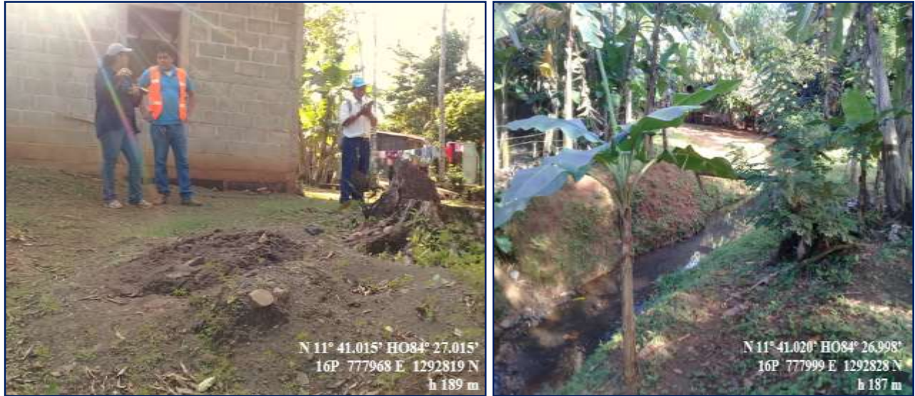
Foto 2. Condiciones del sitio de emplazamiento de la EBAR-3
