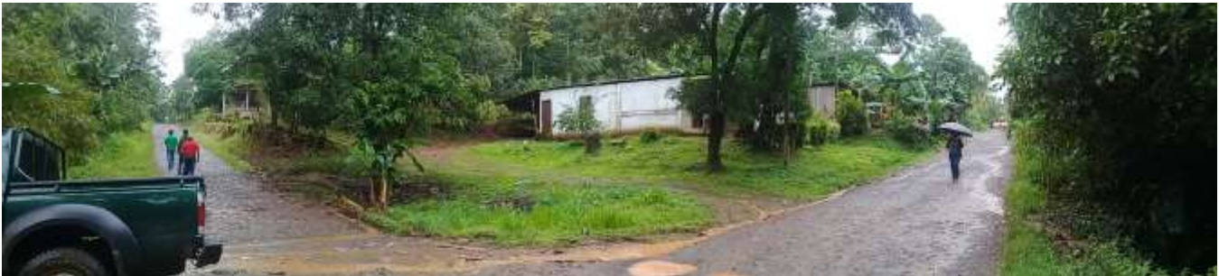
Foto 45. Condiciones de acceso para la EBAS PS 3 ubicada en la Zona 5, en el costado NorOeste de la carretera que conduce a Colonia Río Plata
