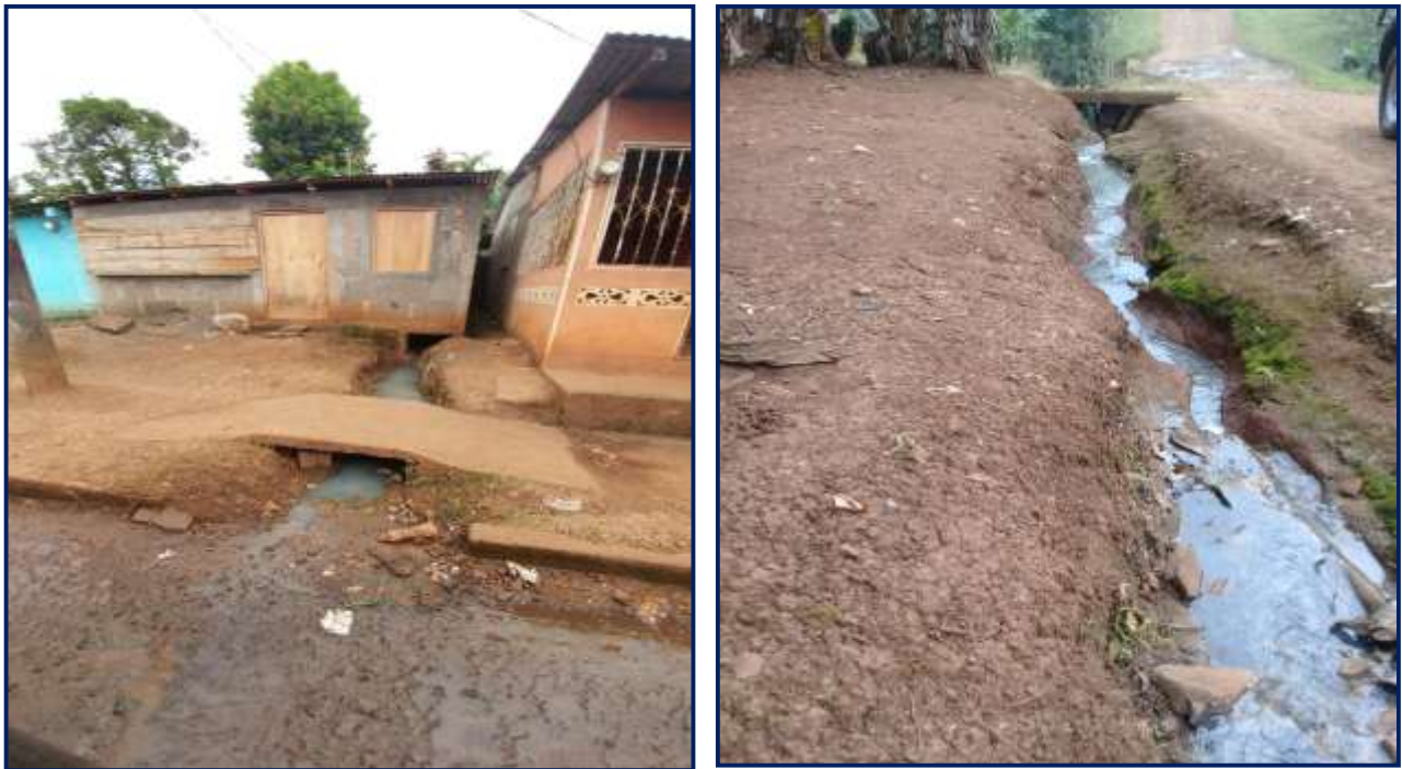
Foto 1. Aguas grises estancadas en los frentes de las viviendas y con destino a las calles Fuente: Treminio, J. (2018)
