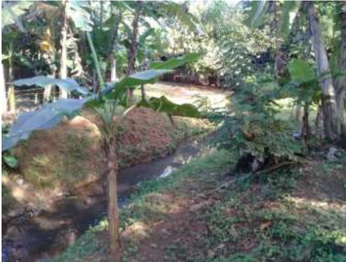
Foto 49. Cauce sin revestimiento que bordea la EBAS PS 2 en su costado Este, captura en época de verano Fuente: Treminio, J. (2018)
