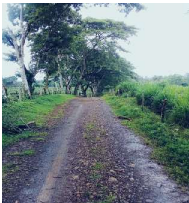
Foto 42. Camino que conduce a la PTAR, sitio La Tamalera
