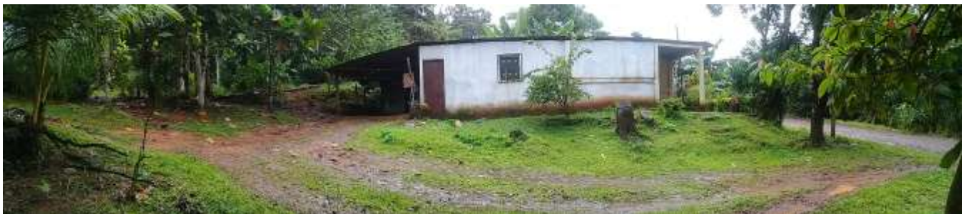
Foto 3. Condiciones del sitio de emplazamiento de la EBAR-2
