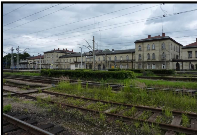
Rysunek 5-10 Widok na budynek dworca kolejowego od strony torów
