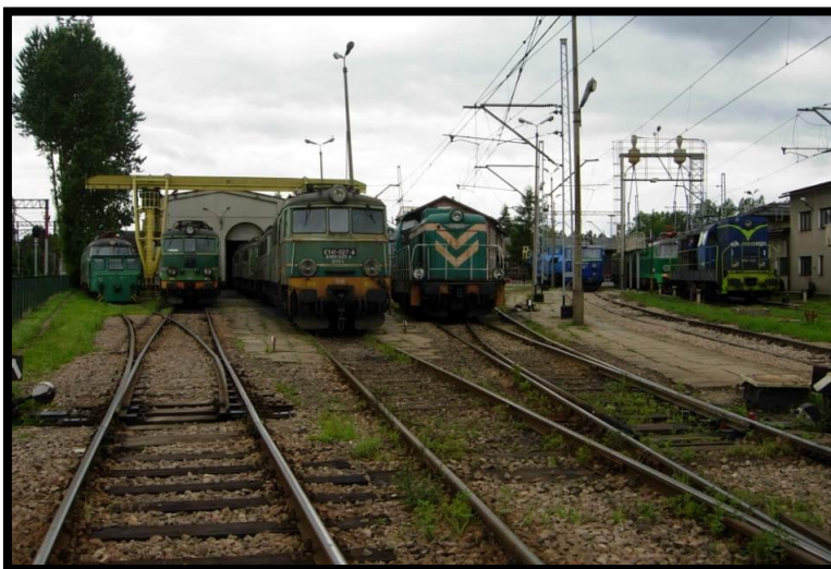
Rysunek 5-11 Widok na zespół zabudowań lokomotywni, w tle hala prostokątna
