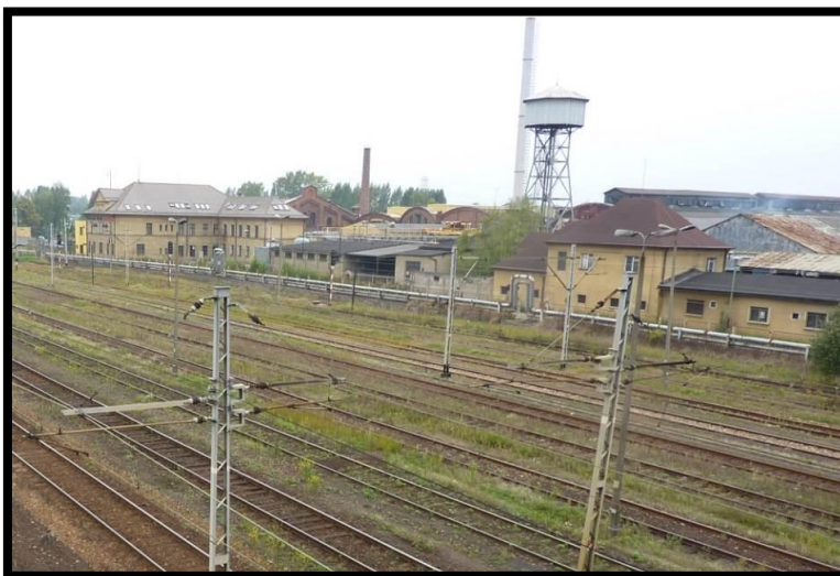
Rysunek 5-12 Widok z wiaduktu na zespół zabudowań Walcowni Metali Dziedzice S.A.
