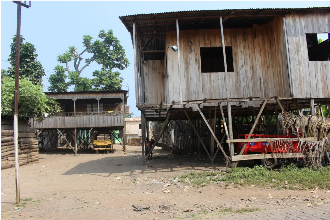
Figura 4-5: Casas em altura em Neves para a proteção contra as enxurradas
