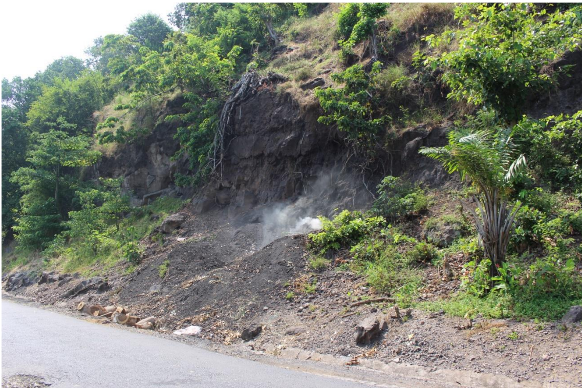
Figura 4-10: Encosta descoberta (extração de pedra)
