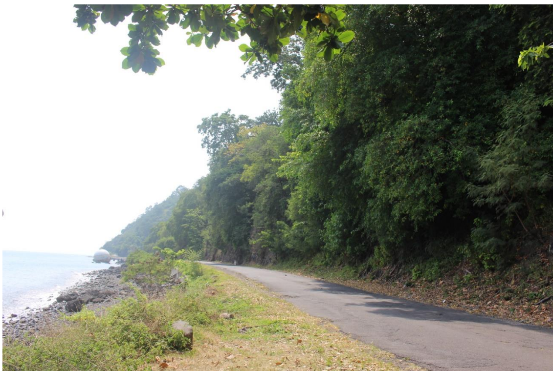
Figura 4-8: Encosta estabilizada com pedra local e cimento
