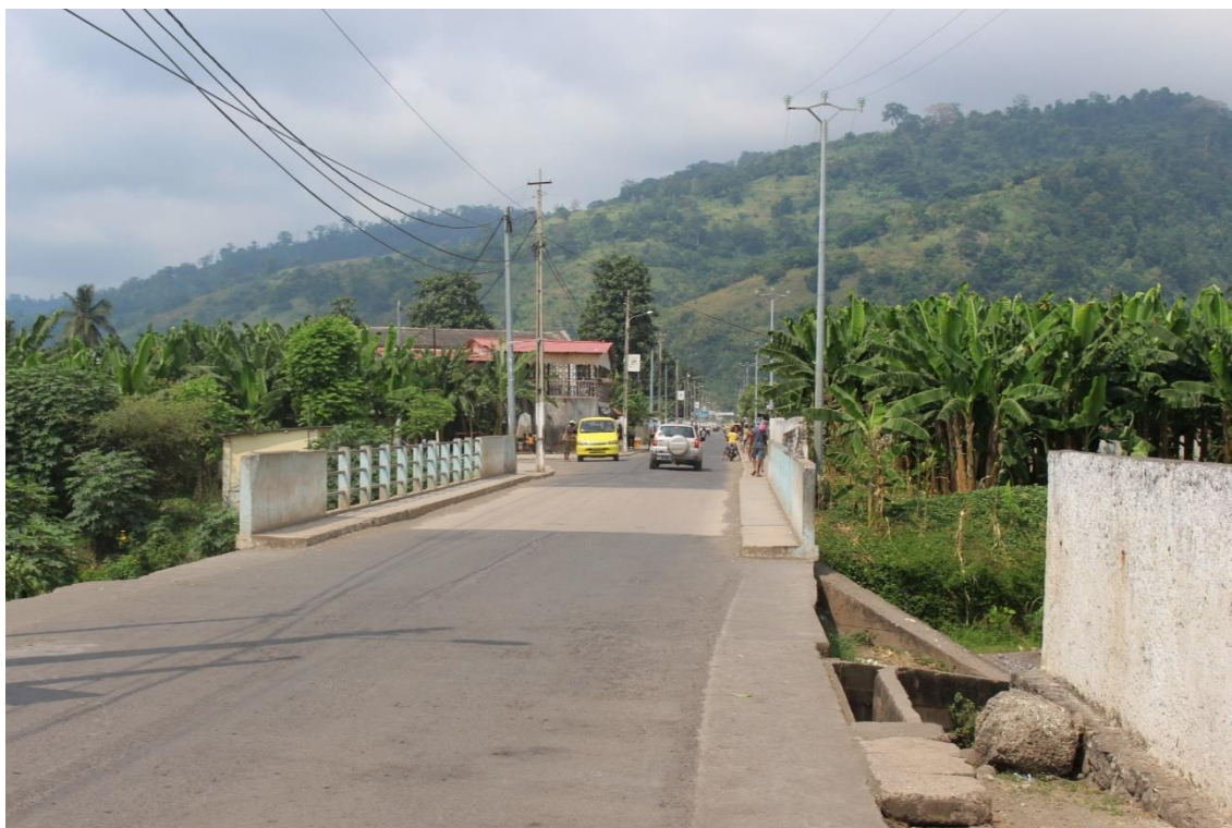
Figura 4-4: Ponte sobre o Rio Provaz
