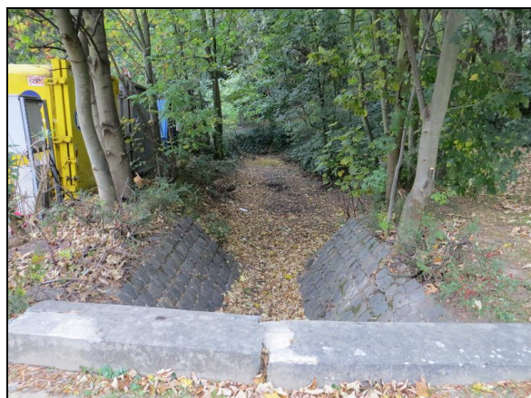
Photo 3 : Bassin d'orage situé dans la zone boisée
