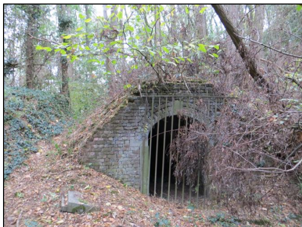
Photo 12 : Entrée d'une ancienne construction militaire
