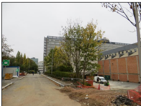
Photo 6 : Talus arboré au niveau du parking P4 - vue éloignée
