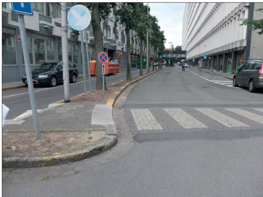
Photo 4 : Voirie interne entre les bâtiments M/L et P/N
