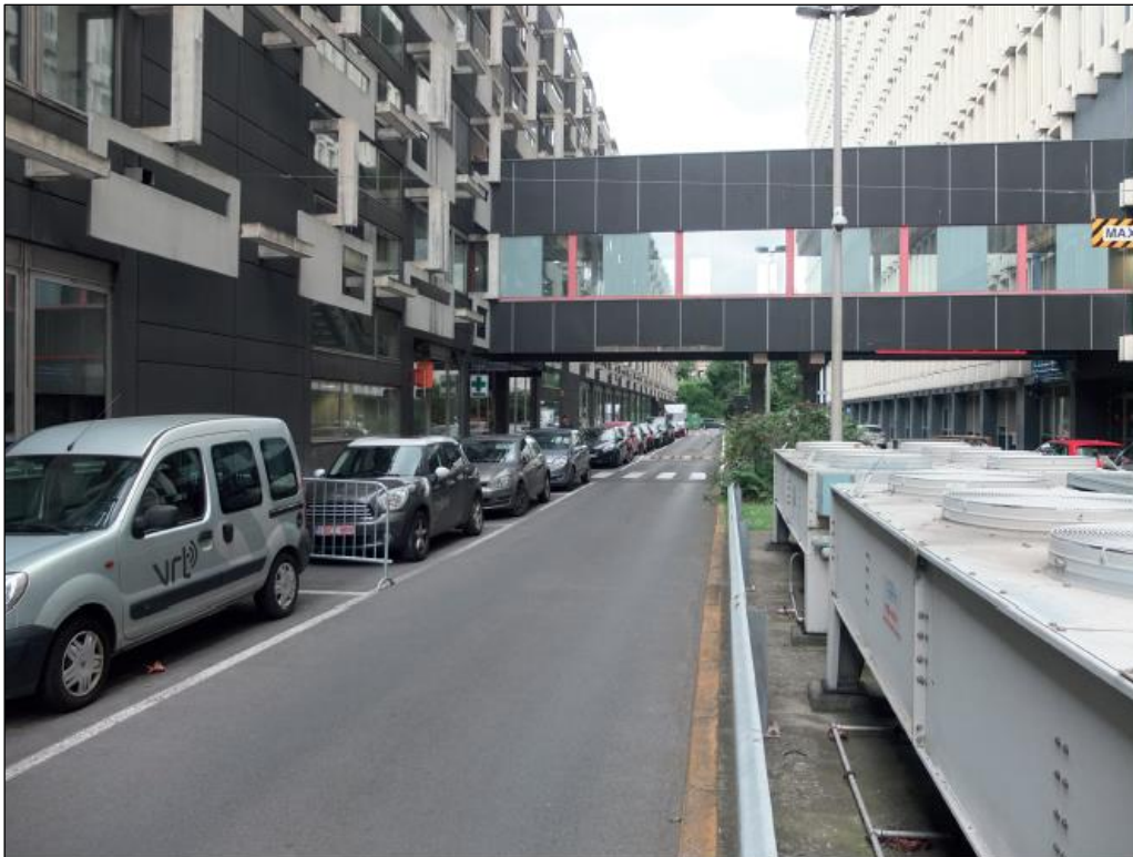
Photo 5 : Voirie interne entre les bâtiments M/L et P/N & vue sur la galerie A
