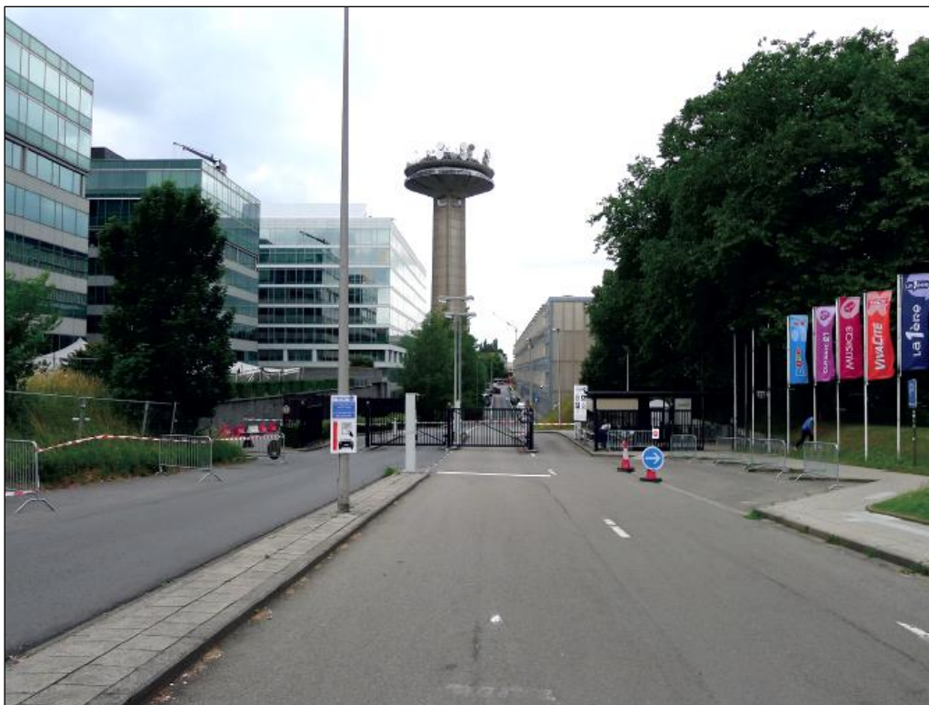
Photo 1 : Accès Diamant dédié à la RTBF
