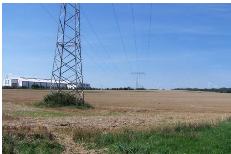
Blick in den Geltungsbereich mit dem vorhandenen Gewerbeobjekt (Firma für Lüftungstechnik)
