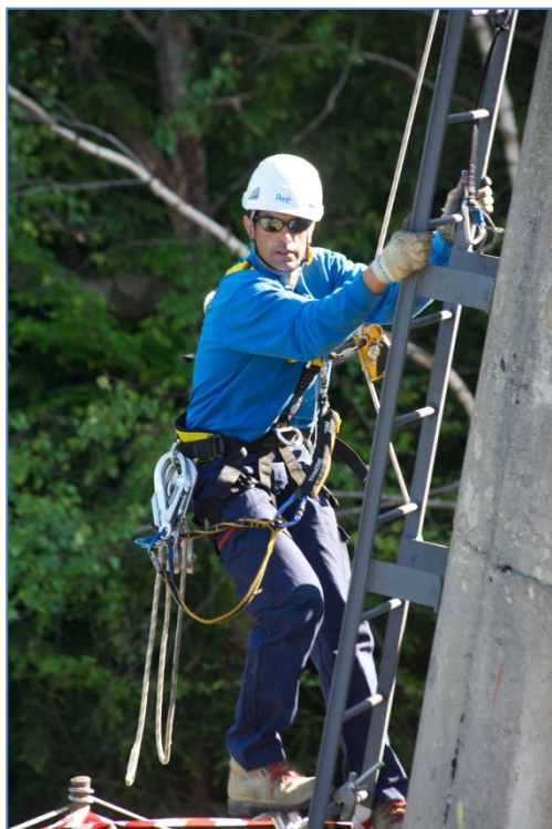
Ascension d'un pylône
