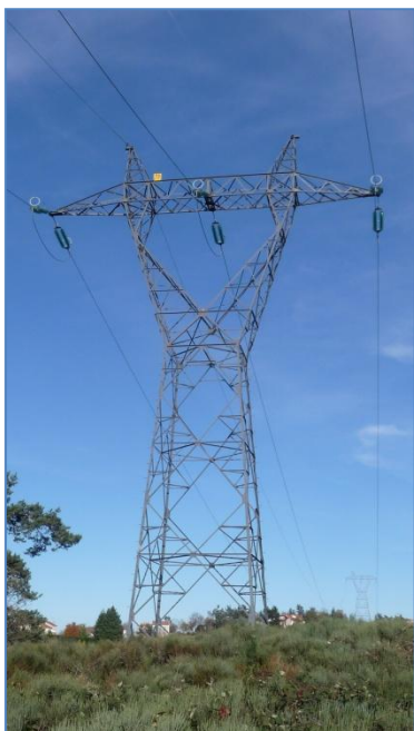
Pylône M1, 1 circuit
