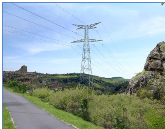
Pylône « Danube », Famille G4D4, 2 circuits Emprise au sol : 45 à 100 m 2 Envergure : 18 à 27 m Hauteur : 34 à 56 m
