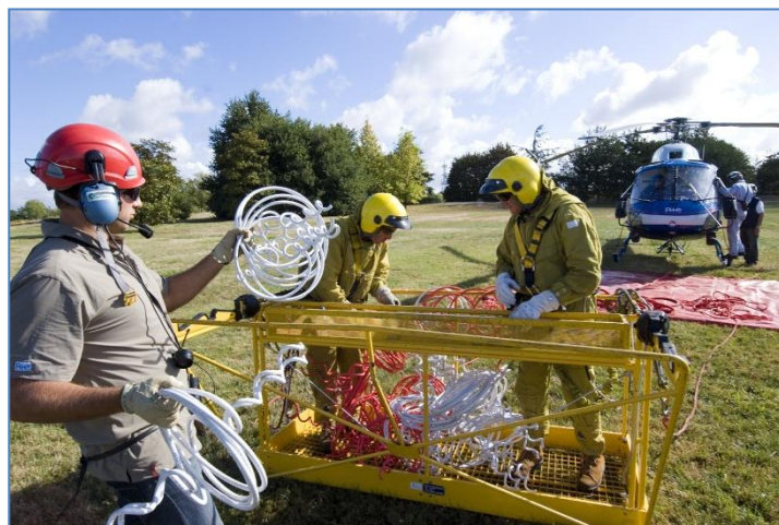
Remplacement de balises avifaune par hélicoptère
