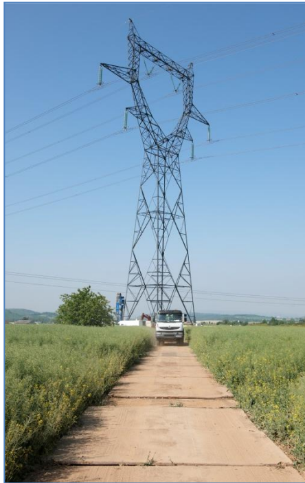
Piste provisoire réalisée avec des plaques de répartition de charge
