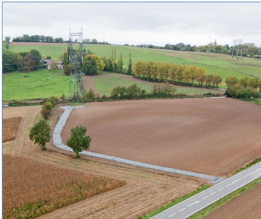
Piste provisoire d'accès à un pylône en bordure de parcelle
