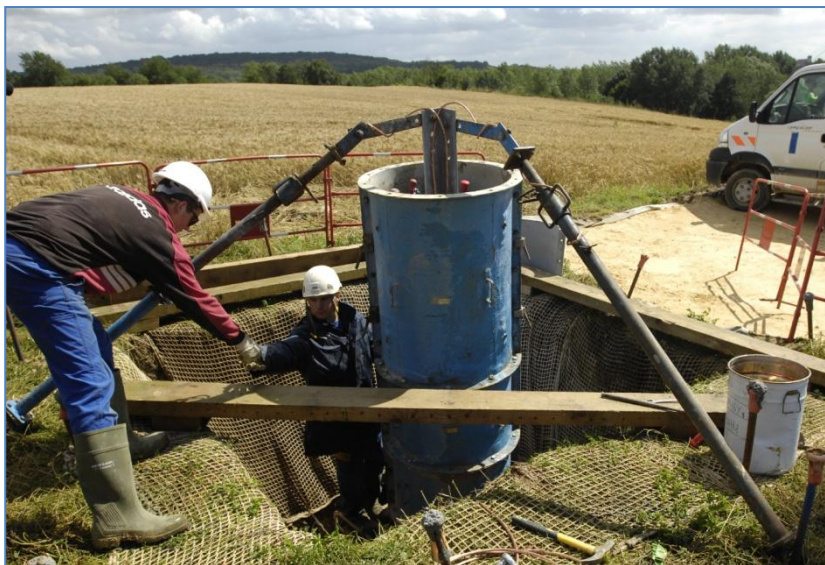
Fondations d'un pylône
