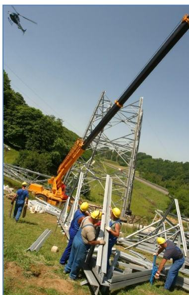
Assemblage d'un pylône
