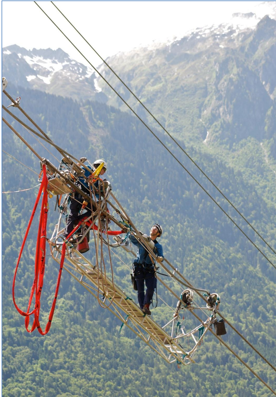
Intervention sur les câbles à l'aide d'une nacelle
