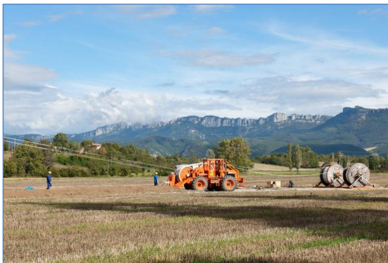
Déroulage des câbles
