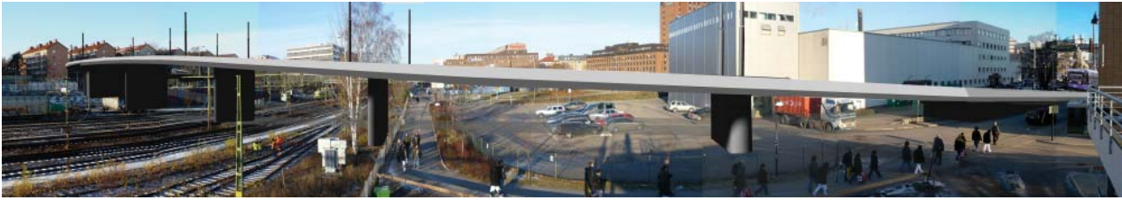
Fotomontage. Vy över Mälarbanans spårområde med Tvärbanans nya bro inlagd i bilden. Foto taget från Ekensbergsbron.
