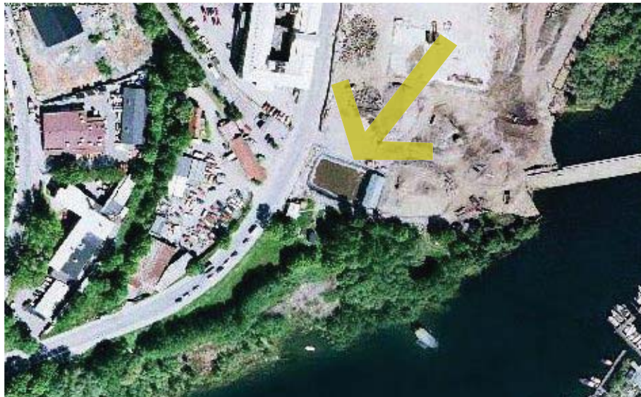
Fastigheten Rostugnen 6 med avvattningsbassängen
