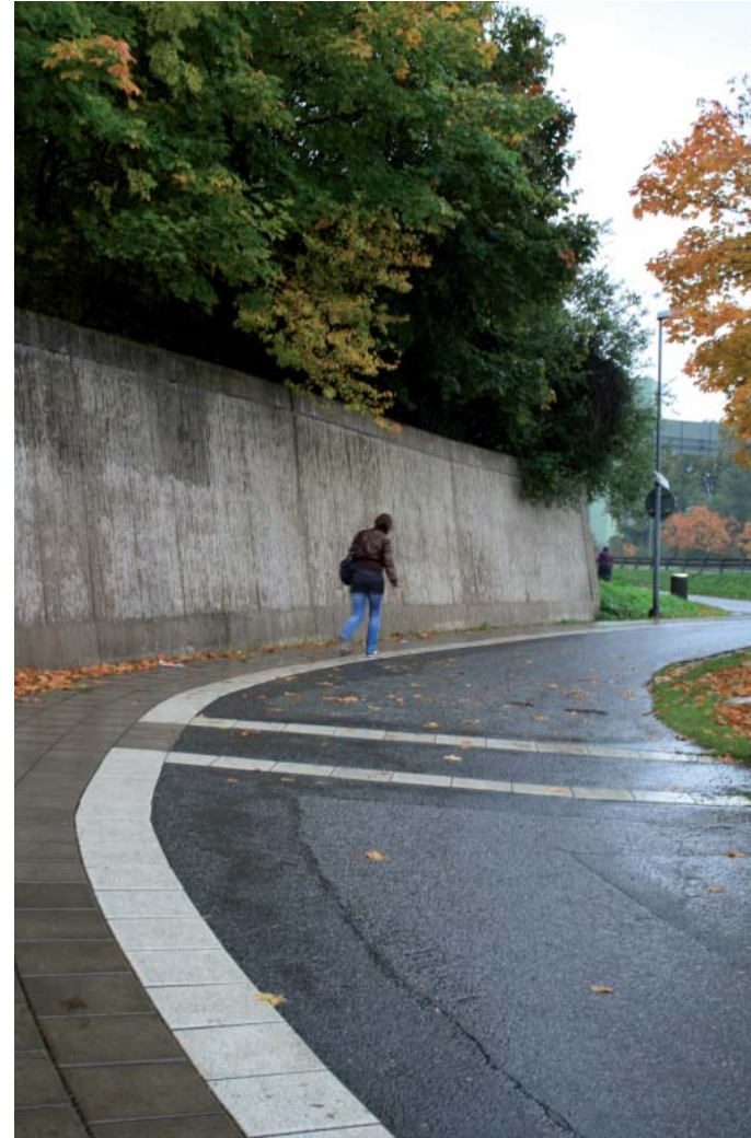
Bild 3.7. Stödmur vid gång- och cykelvägen nedanför kv. Nordan.
