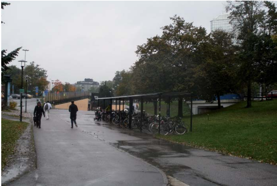
Bild 3.5. Gång- och cykeltunnel under Frösundaleden.
