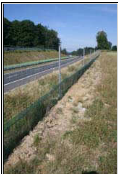
Fot. 5.24 Przykład ogrodzenia ochronnego (droga ekspresowa S1) [98]
