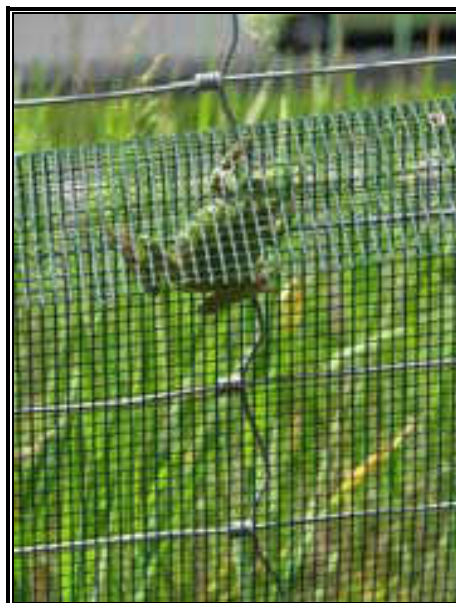
Fot. 5.25 Siatka o drobnych oczkach z przewieszką zabezpieczająca płazy przed wejściem na jezdnię [98]
