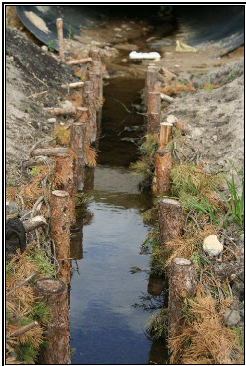
Fot. 5.20 Przykład cieków umocnionych kiszka faszynową
