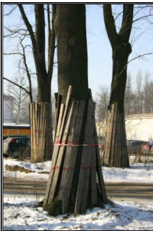
Fot. 5.17 Przykładowy sposób ochrony pnia drzewa przed uszkodzeniami związanymi z pracami wykonywanymi w jego pobliżu
