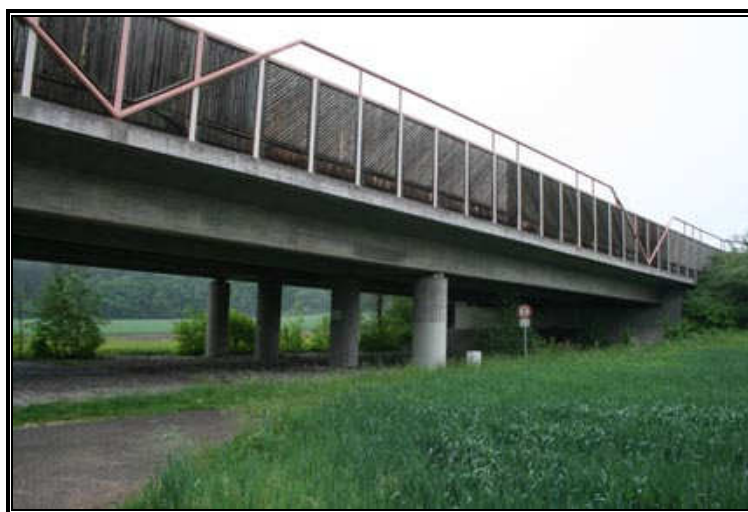
Fot. 5.23 Przykład osłon antyolśnieniowych na przejściu dolnym dla dużych zwierząt
