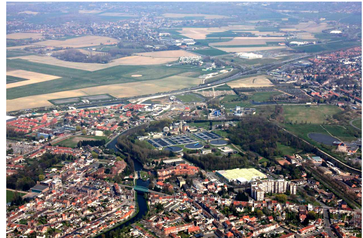
CARTE 3 : VUE AERIENNE DE L'ACTUELLE STATION D'EPURATION
