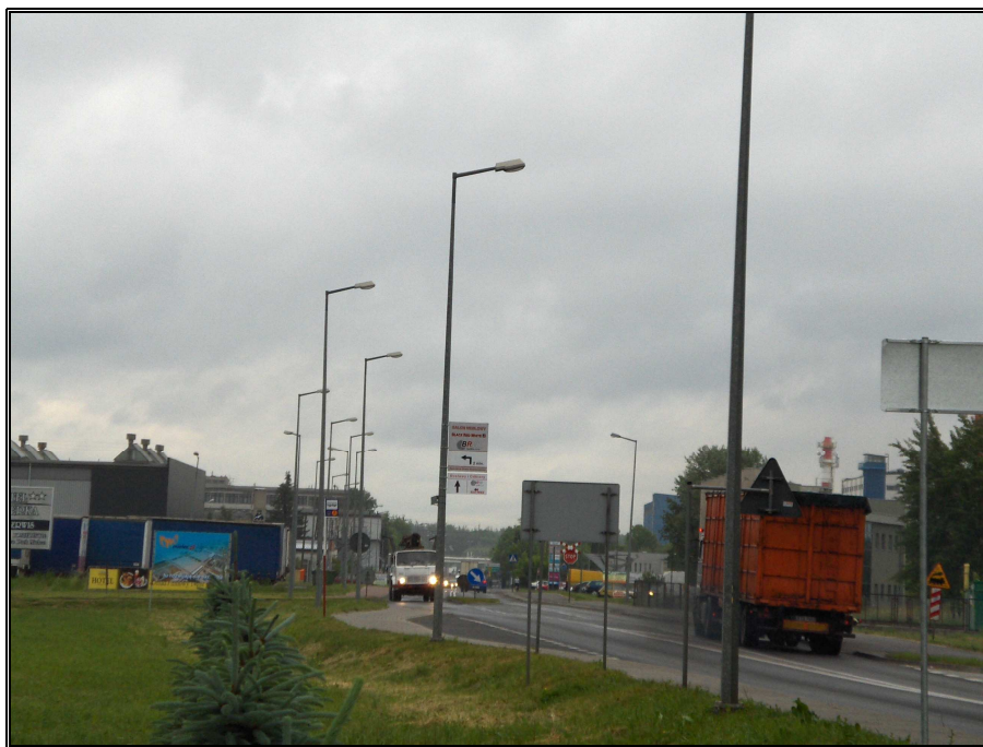
Fot. 4 Panowana do przebudowy droga na terenie SSE Mielec
