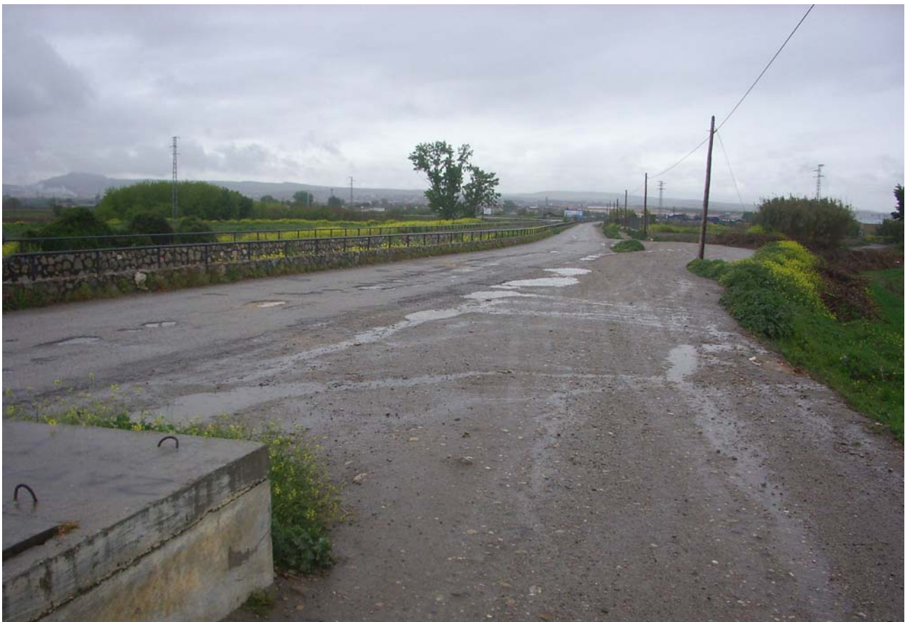
FOTO 2. INICIO DEL PARALELISMO CON EL RÍO BEIRO
