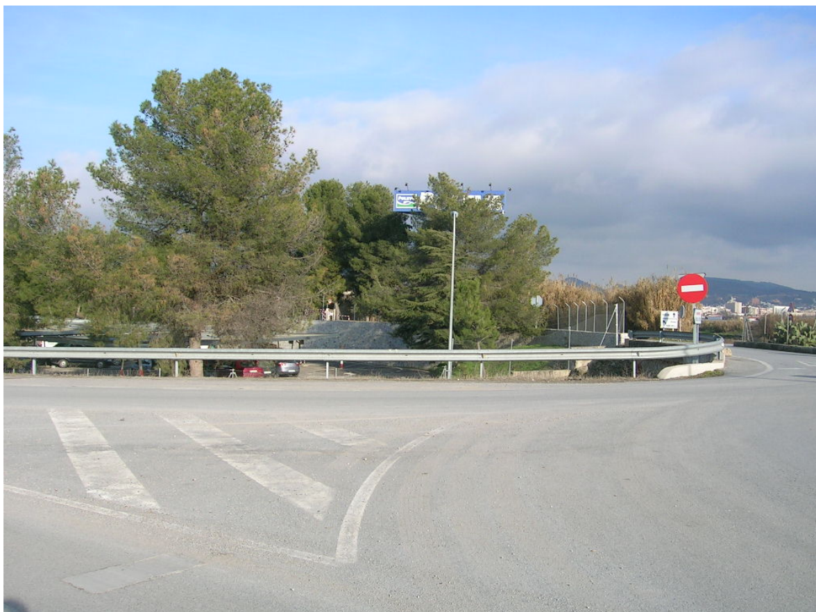
FOTO 4. PARTE INICAL CRUCE CON ACEQUIA GORDA Y CTRA GR-3418
