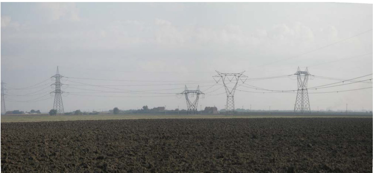
Foto 16 - Vista dell'area in prossimità della stazione di Foggia. La linea esistente (binata) verrà sostituita da quella trinata
