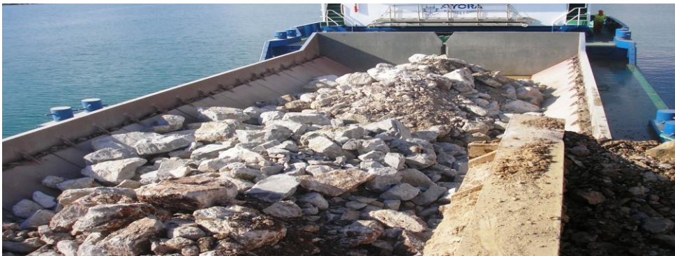
Gánguil cargado (escolleras)
