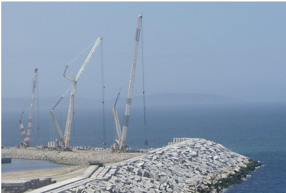
Grúas para colocación de bloques en protección
