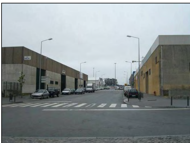
Fotografia 4.3 – Pavilhões Industriais – Rua Veloso Salgado
