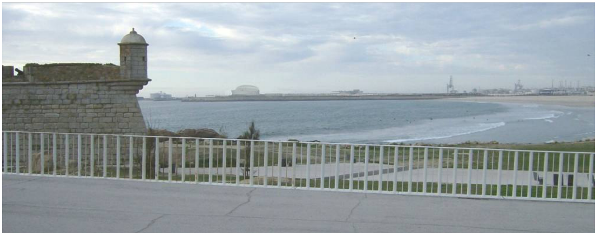
Foto 7 – COM VISIBILIDADE PARA O EDIFÍCIO – Castelo do Queijo (foto SE/NW).
