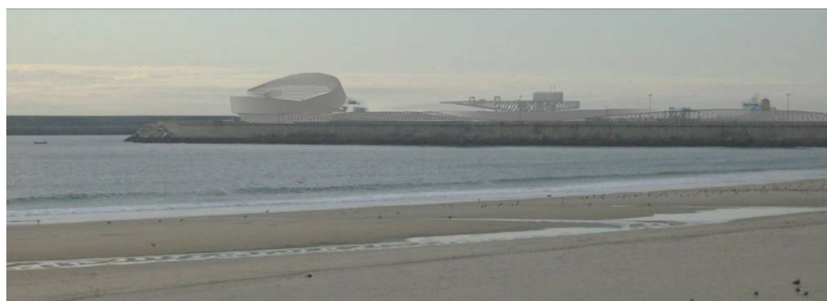
Foto 6 – COM VISIBILIDADE PARA O EDIFÍCIO – Rotunda da “Anémoma” (foto SE/NW).
