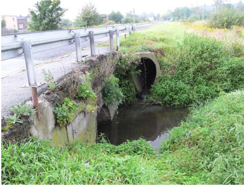
w rejonie ulicy Szałasownizna (zadanie 4)
