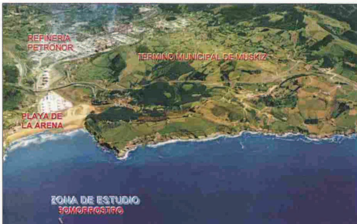
figura 2.- Vista aérea de la costa perteneciente al Término Municipal de Muskiz
