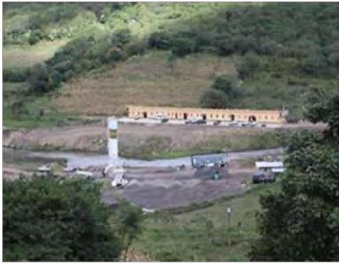
Plantel de construcción SE Larreynaga
