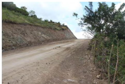
Camino sin Pavimento rumbo a subestación Larreynaga
