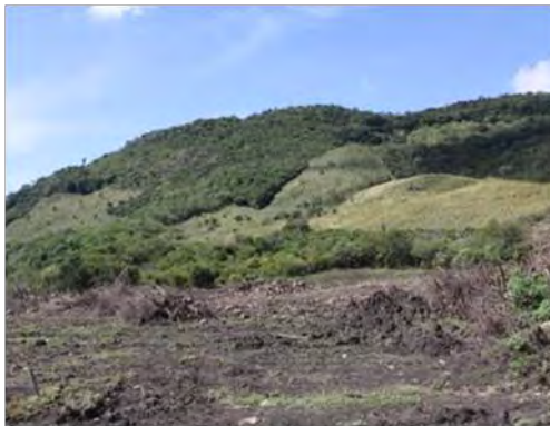
Sitio donde se construye la SE Larreynaga
