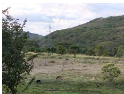
Línea de transmisión existente Estelí - Yalagüina
