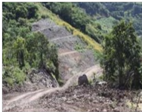
Taludes y camino de acceso a SE Larreynaga
