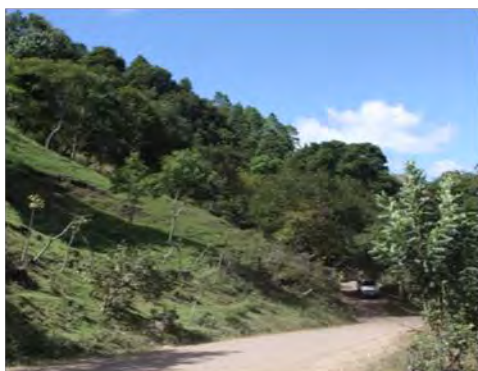
Carretera Yalí - Condega
