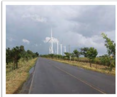
Foto No. 10.- Parque Eólico Amayo, sobre la carretera Rivas – Peñas Blancas
