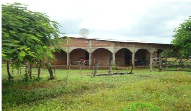
Foto No. 28.-Vivienda cercana a la carretera internacional
