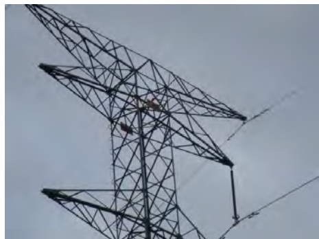
Foto No. .- Brazos libres de torre del tendido eléctrico SIEPAC
