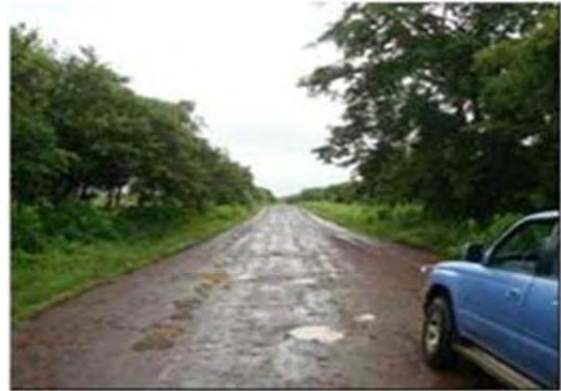
Foto No. 6.- Condiciones del derecho de vía del camino de acceso secundario La Paz Centro - Malpaisillo, en donde se construirá la línea de transmisión natural producto de la ganadería extensiva
