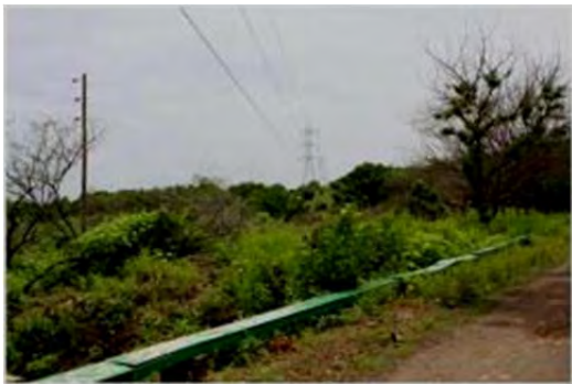
Foto No. 3.- Tendido de conductores LT hacia SE Planta Momotombo
