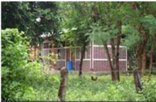
Foto No. 21.- Vivienda de Concreto
