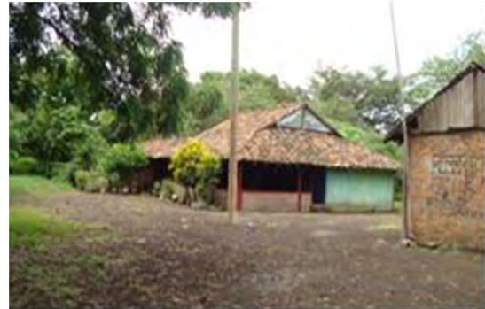
Foto No. 22.-Vivienda de Finca
