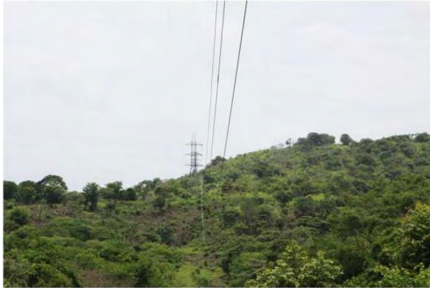
Foto No. 26.- Área de servidumbre de la de la infraestructura actual, en la zona núcleo de la RN Momotombo
