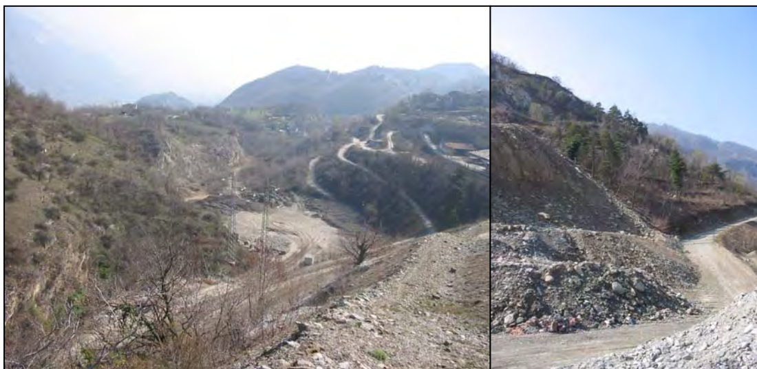
SITO CANTALUPO - PIAN BARALE- Vista del sito di deposito
