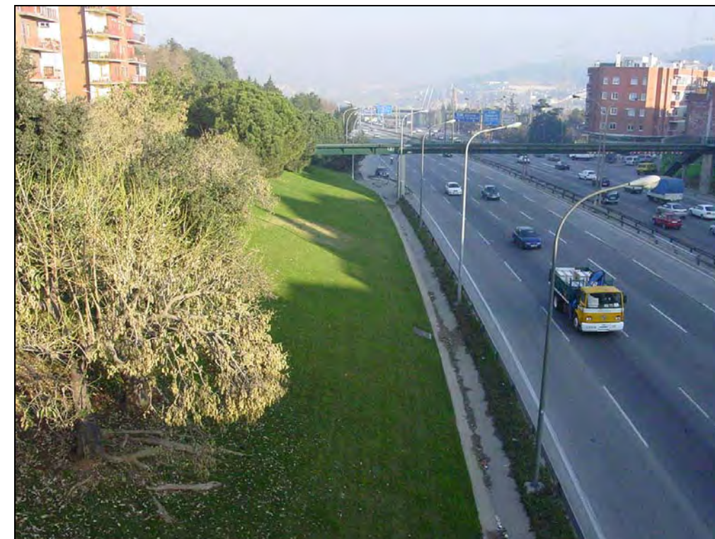
Fotografia núm.11: Visual de talussos de l'Avda. Meridiana afectats pel corredor proposat
