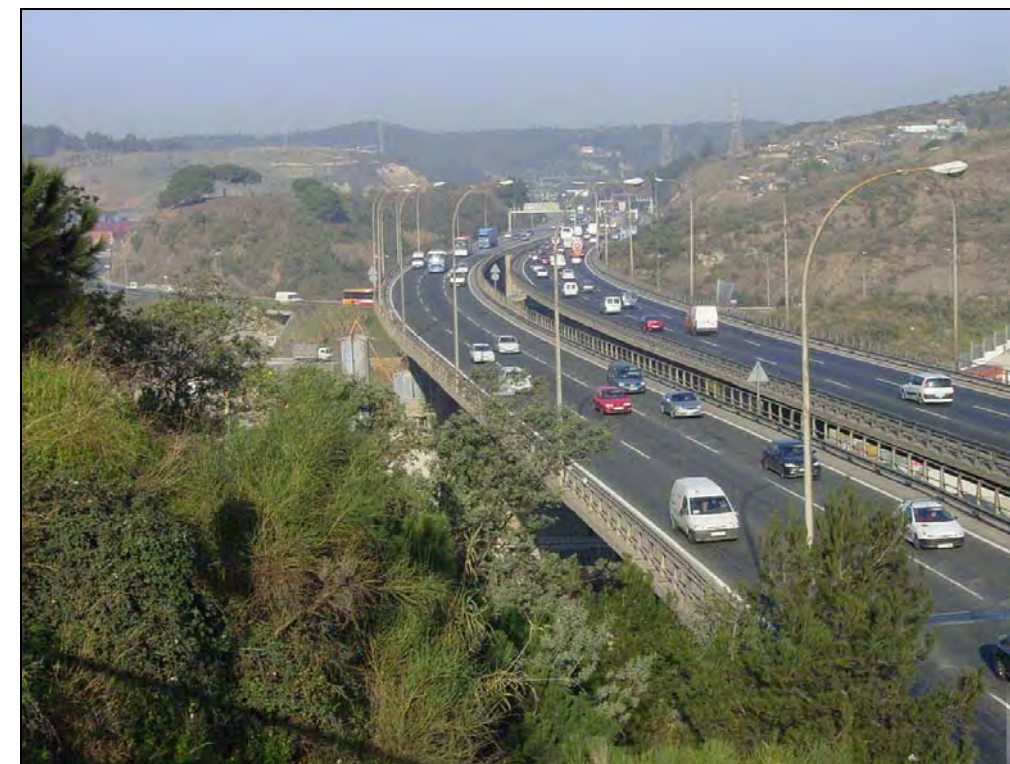
Fotografia núm.7: Visual de la C-58 en viaducte sobre de la carretera N-150.
