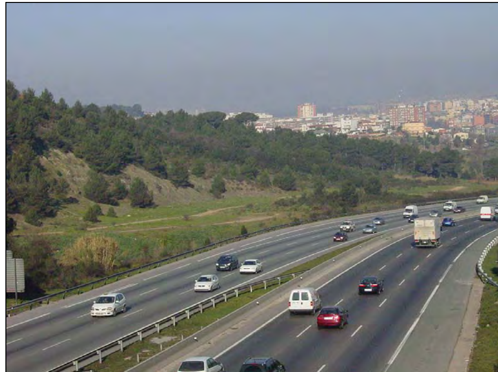
Fotografia núm.2: Visual de zona afectada a l'inici del traçat, aproximadament al PK 2+600, on al marge dret del traçat afecta superfície que forma part del PEIN de la Serra de Collserola.
