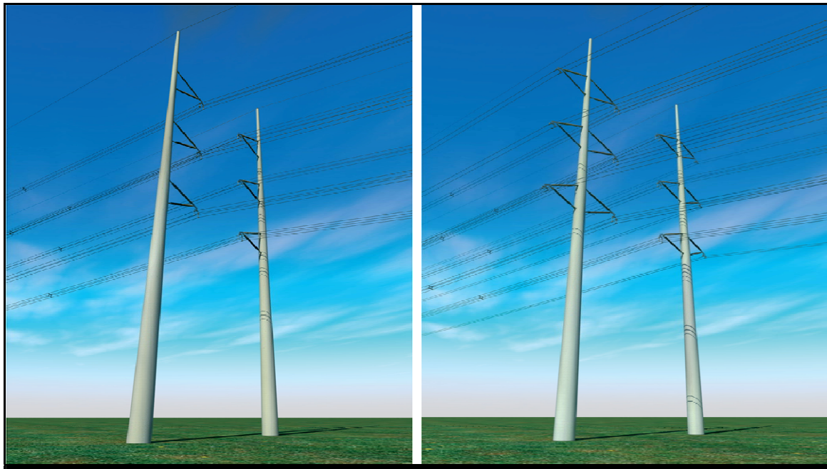
Figuur S2.1 380 kV mast en combinatiemast 150 kV en 380 kV
