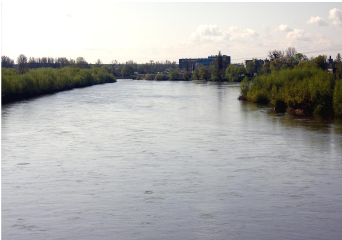
Fot. 2. Rejon planowanej zabudowy progu piętrząco- stabilizującego na rzece San.
