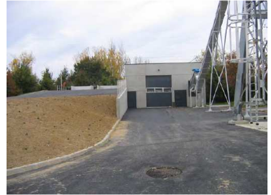
Unité de traitement des sables
