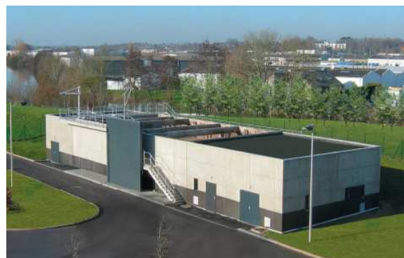
Unité Biolix de traitement des graisses
