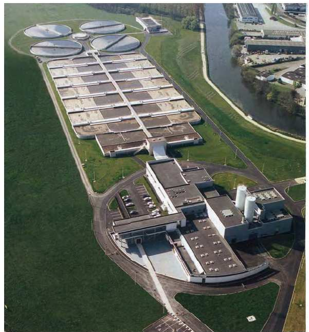
Station d'épuration de Beaurade
