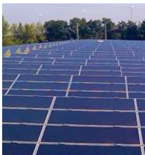
Figura 3.2: Moduli fotovoltaici a film sottile a base di telloruro di cadmio
