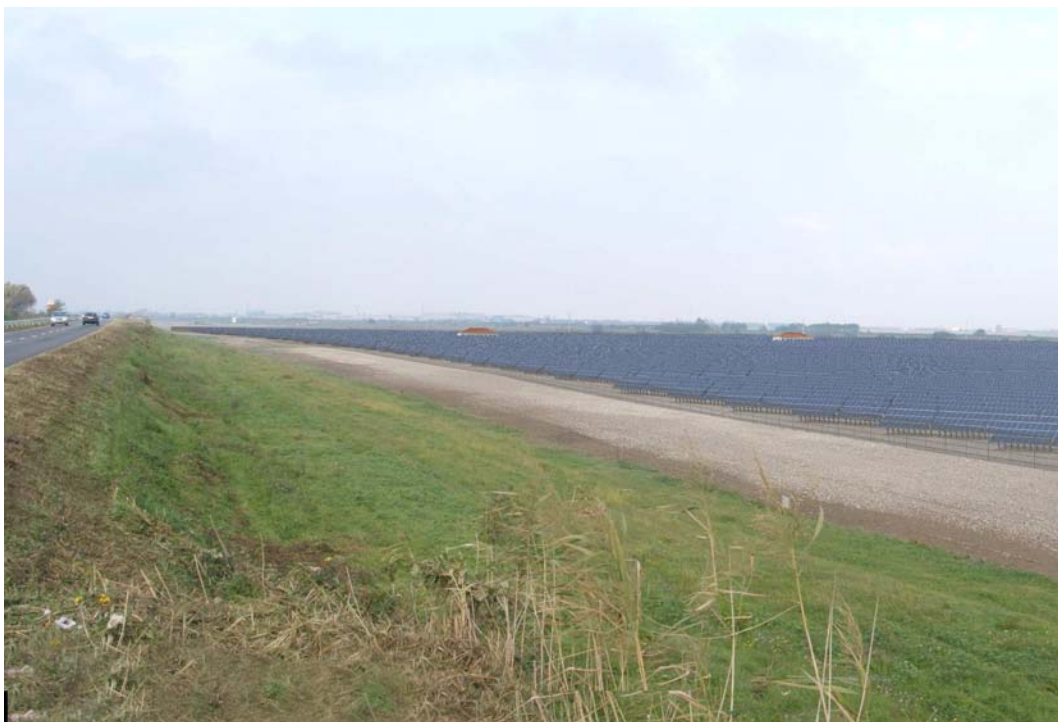
Figura 5.8: Scorcio dalla S.P.41 verso ovest – post operam.
