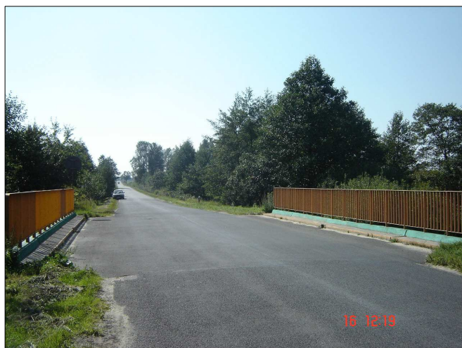
Fot. 2-5 Droga wojewódzka nr 987 w miejscu przecięcia z planowaną autostradą
