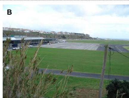
Zona de ampliação da plataforma W
