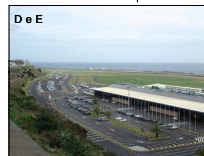
Lado terra e zona de construção de caminhos D e E
